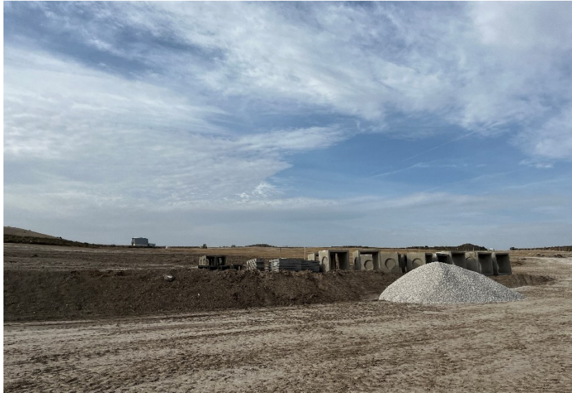
Figura 4 Zona de acopio de material de construcción
