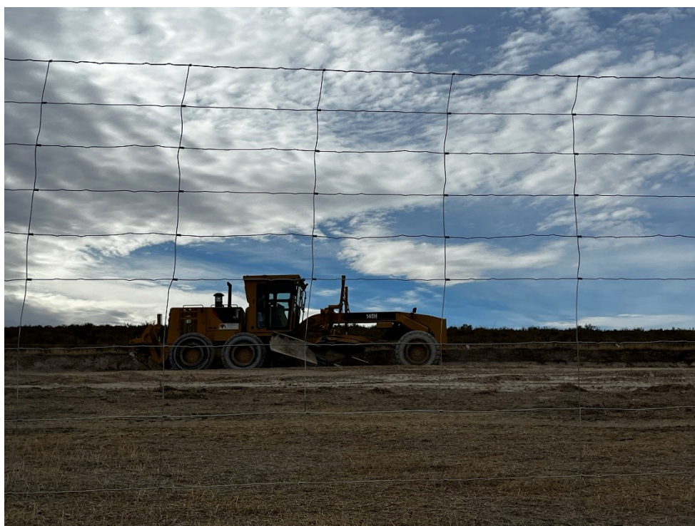
Figura 9 Apertura de viales
