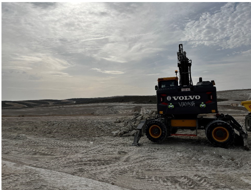
Figura 2 Trabajos de movimientos de tierras
